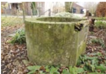
Een typische waterput uit het Gelderse rivierengebied: een put met een vlakke kant en een houten stoep voor de emmer in Doornenburg.
