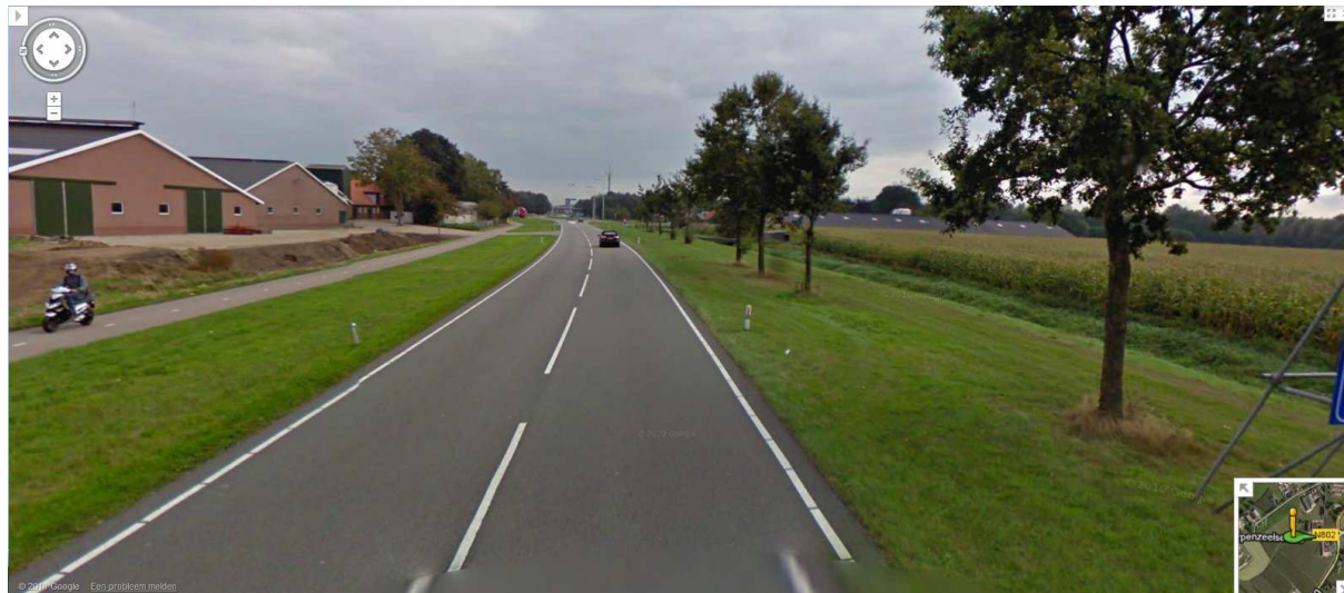
N802 Scherpenzeelseweg in oostelijke richting nabij de oprit van de A30 bij Barneveld
