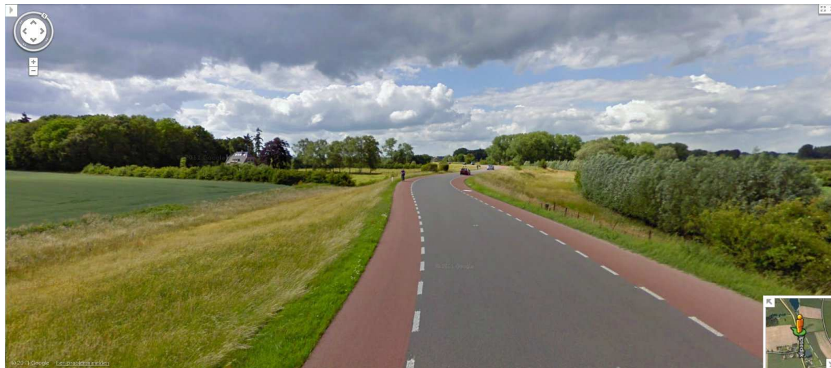
N790 Wilpsche dijk ter hoogte van de Lazaruskolken in noordelijke richting
