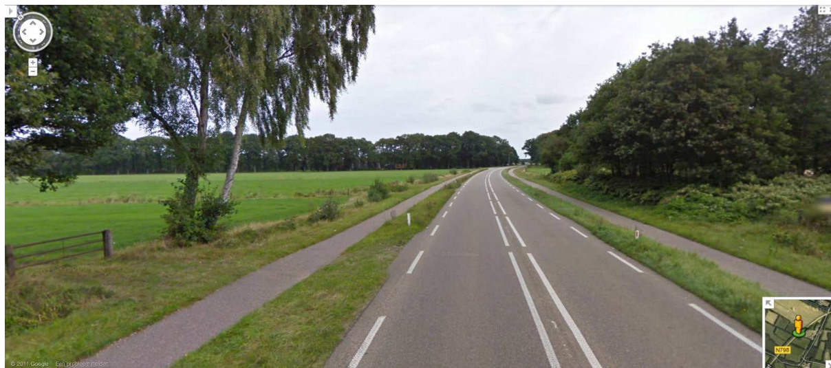
N798 Nijkerkerstraat ter hoogte van Oldenaller in noordoostelijke richting
